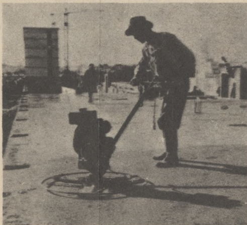
Les ouvriers sont équipés de machines modernes ; ici une surfaceuse pour égaliser le sol en ciment.
